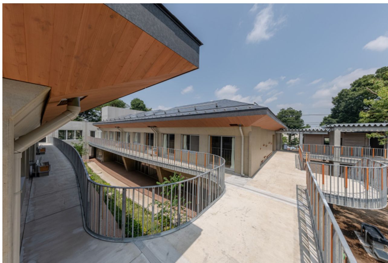
教室のバルコニーをつなぐ屋外渡り廊下
