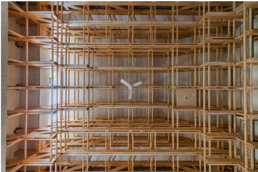
教室の架構の見上げ
