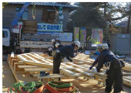
現場での地組み
