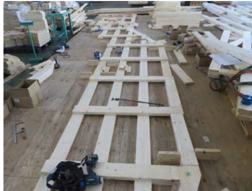
2×4規格材による工場でのフレーム製作
