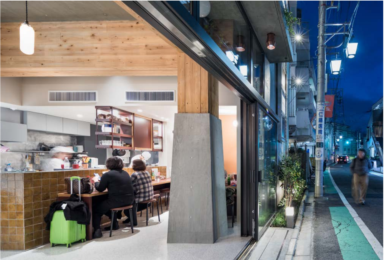
街路より1階店内を見る 木造束ね柱・重ね梁のフレームがよくわかる
