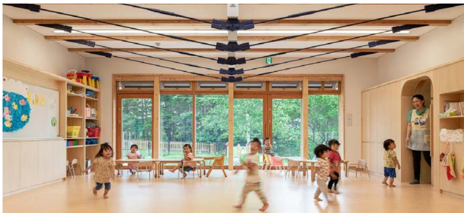
張弦梁架構の保育室
