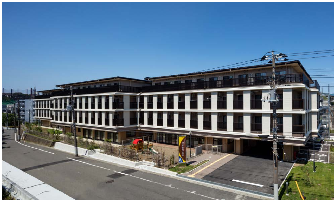
南側からの全景
