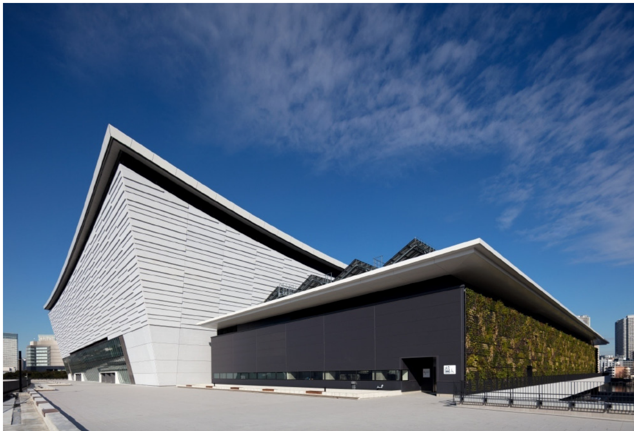
南西側からの外観 手前にサブアリーナ、その奥にメインアリーナ
