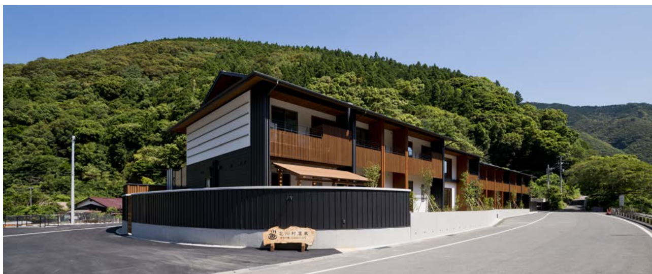
南側からの外観
