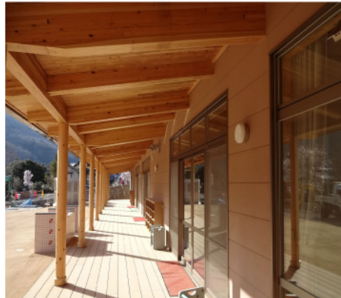
園庭に面したテラス
