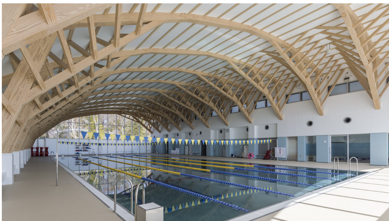
プール棟の内観
