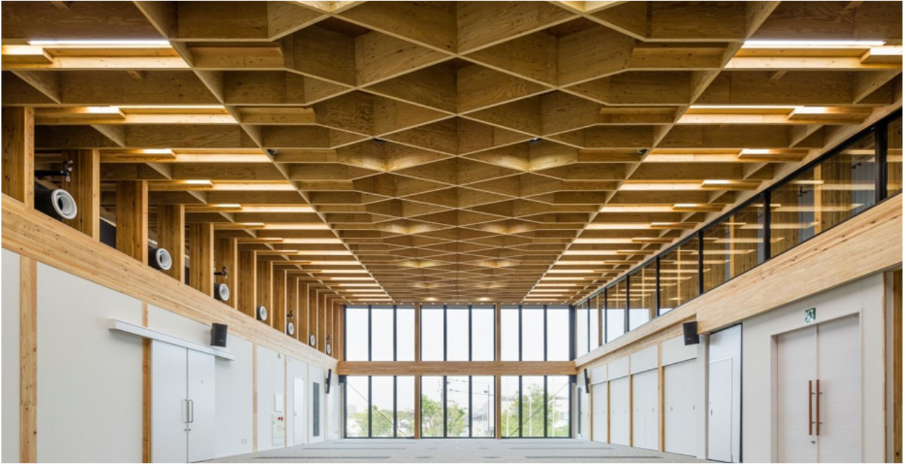
大会議室 ゲルバー桁橋の屋根架構
