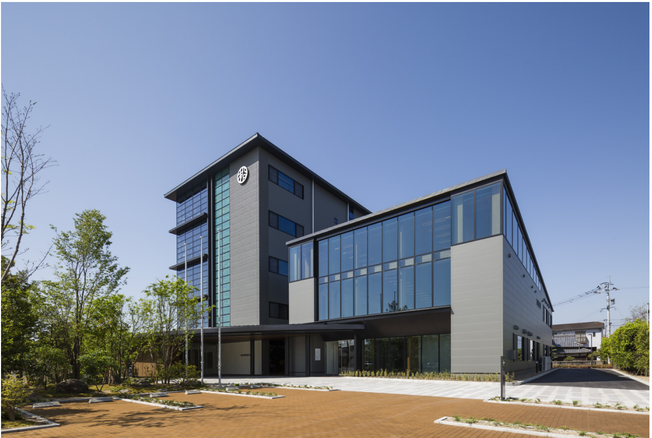
北東面外観 左：事務所棟、右：会議室棟
