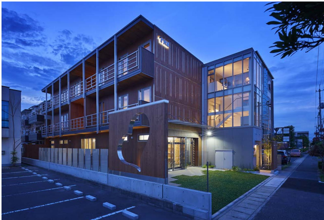
東側からの外観（夕景）
