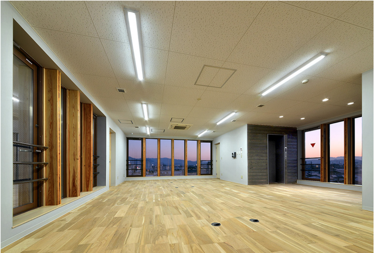
4階事務所内観 サッシュ方立に CLT 材を採用
