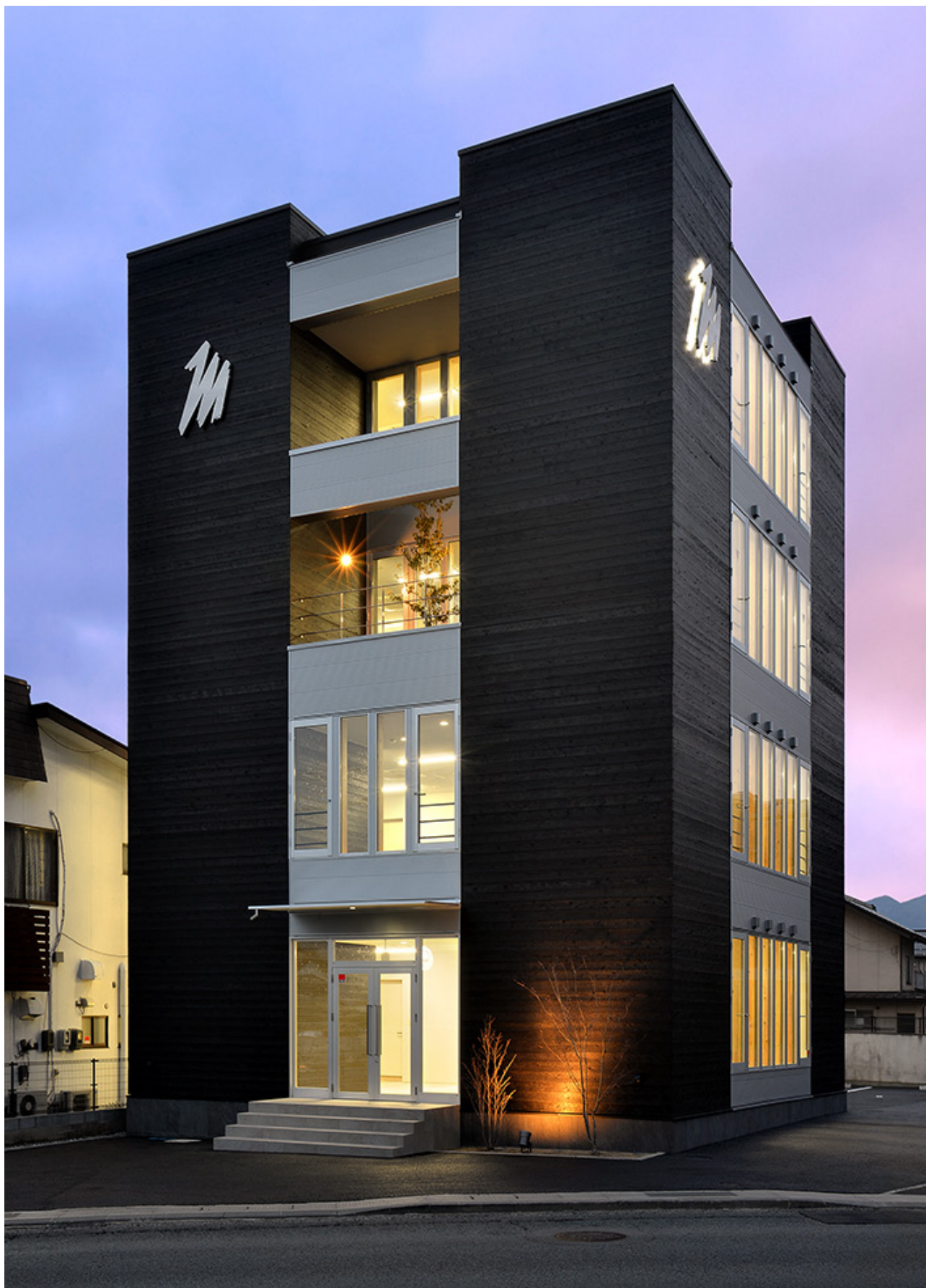
北東面外観（夕景）。外装仕上げ材は焼杉（ノブラシ）
