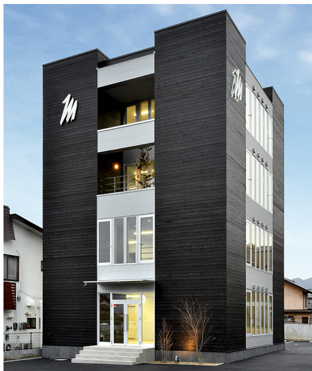
北東面外観全景
