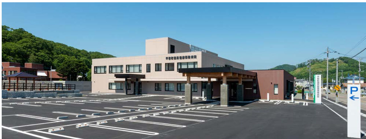
南側からのエントランス側外観
