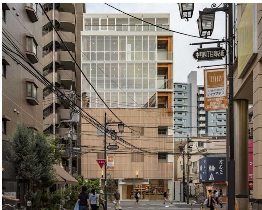
北側から見る外観
