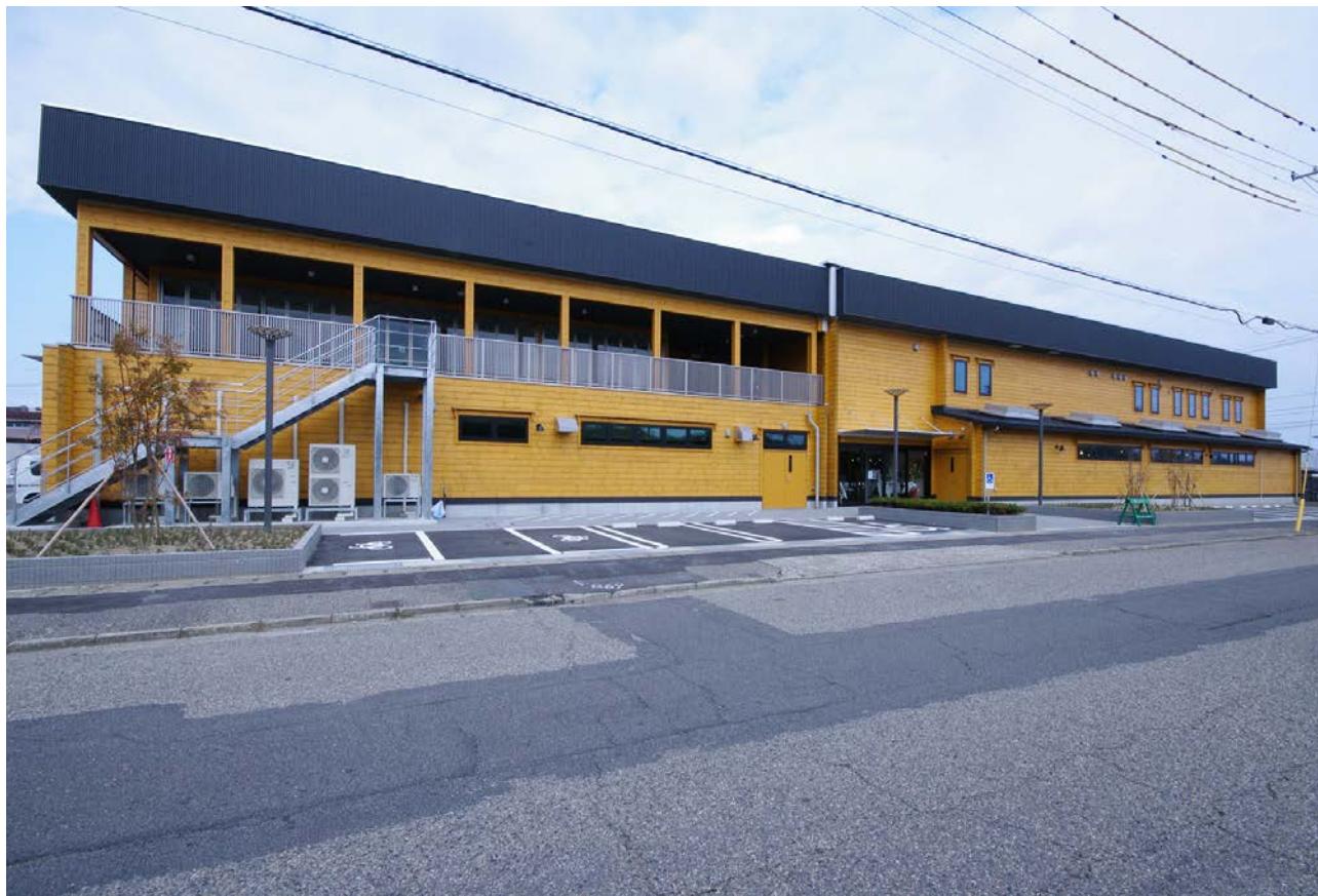
南側からの外観
