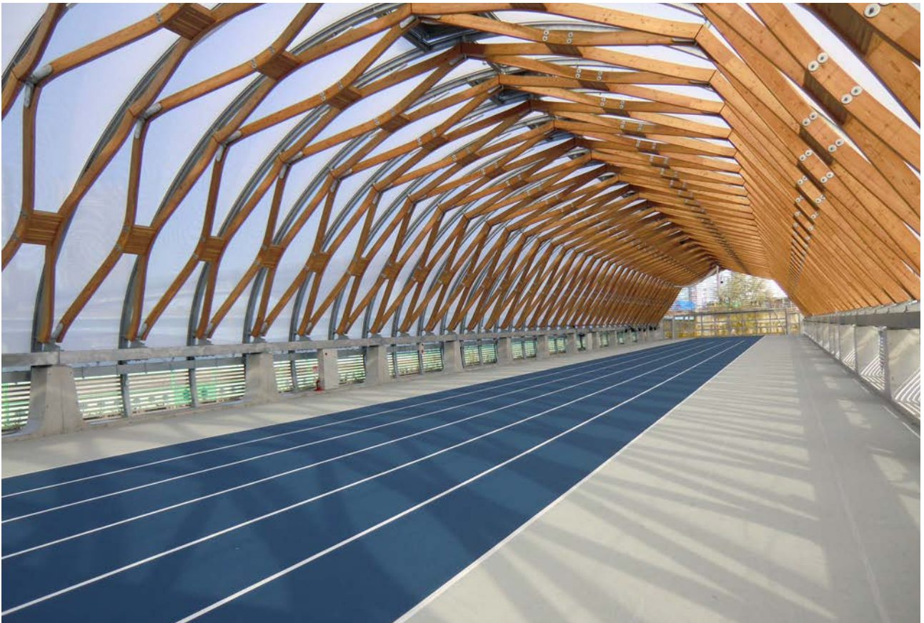
60mトラックを包みこむ18mスパンのアーチ構造の内観
