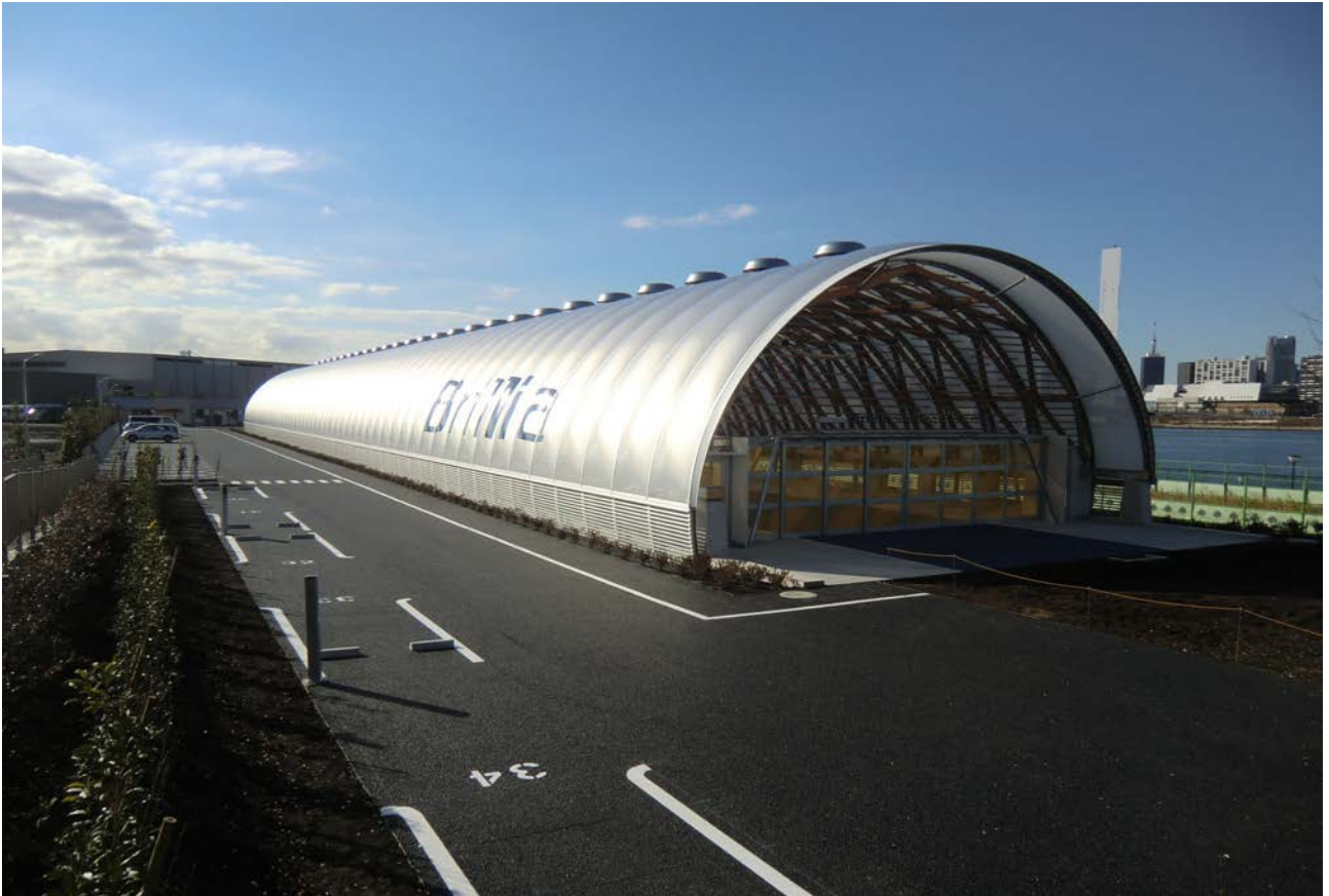
東側からの外観
