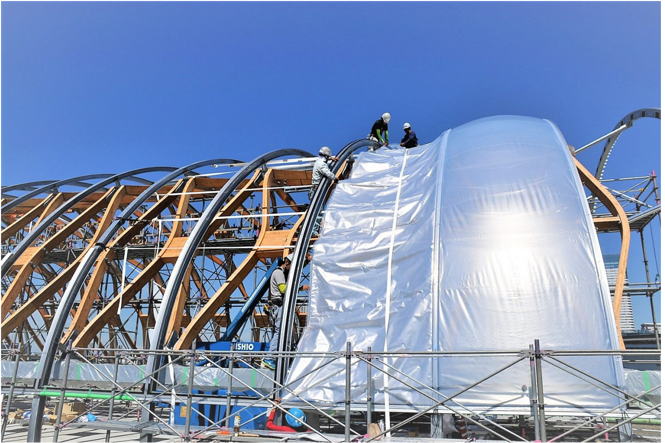
構造フレームの外観。外装のETFEの取り付けの様子
