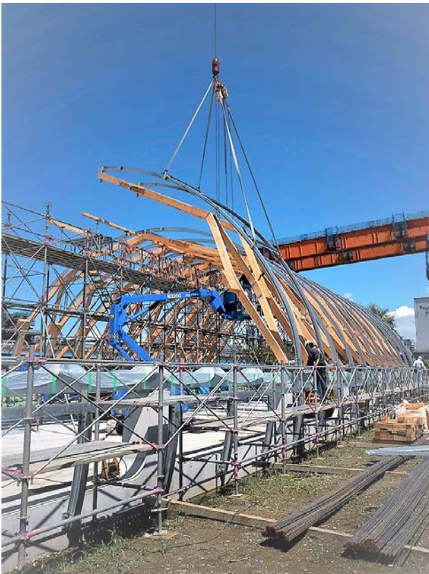
構造フレームの建て込み風景
