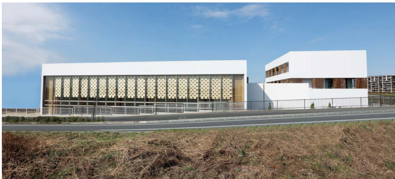
幹線道路側(東側)からの外観(左が実習棟、右が事務所棟)
