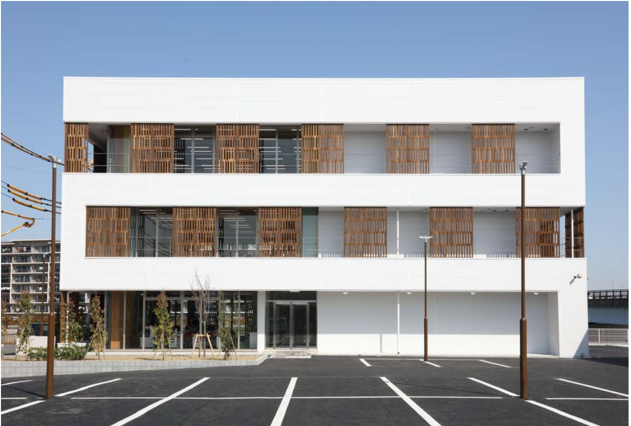
事務所棟の北側外観
