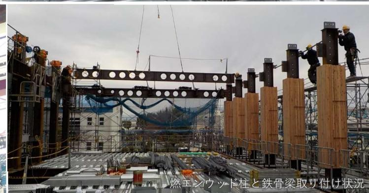
燃エンウッド柱と鉄骨梁取り付け状況
