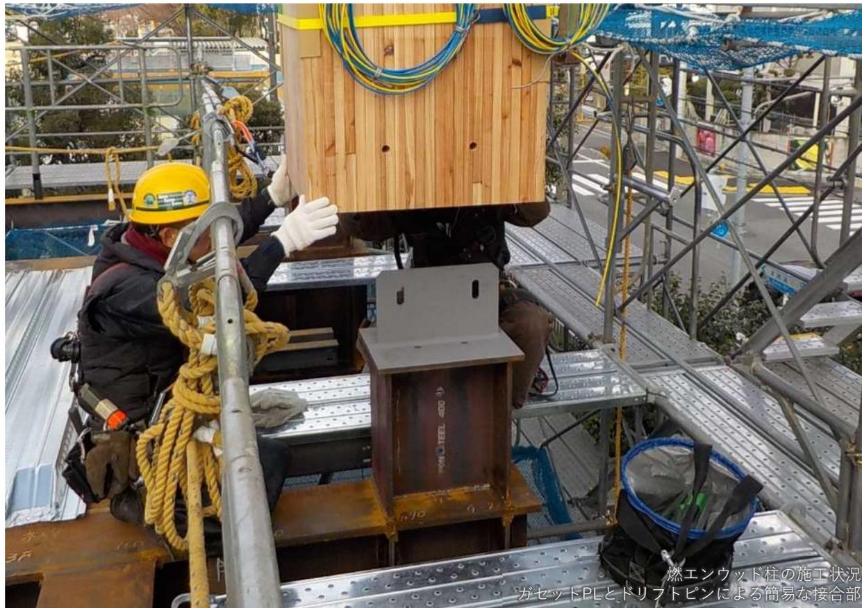
燃エンウッド柱の施工状況
