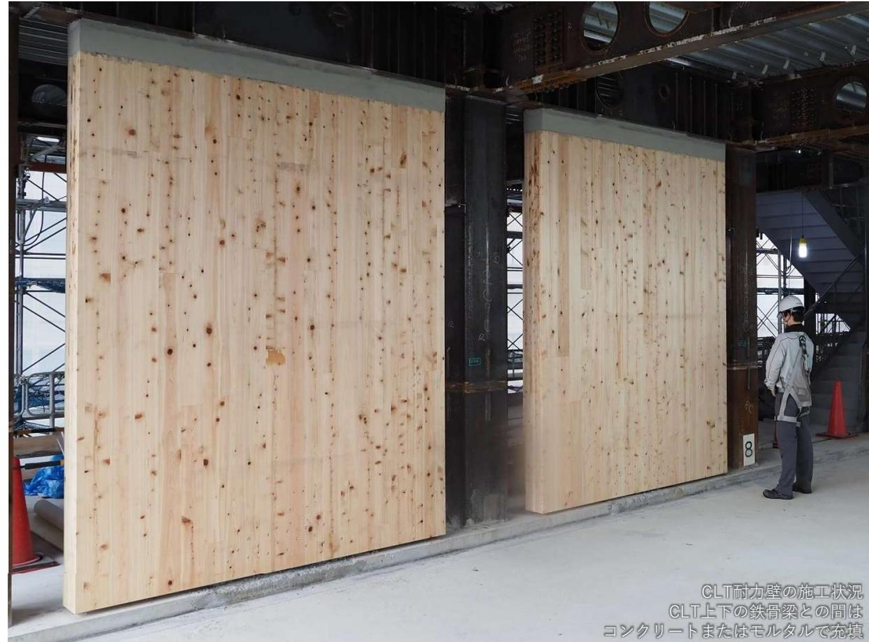
CLT耐力壁の施工状況
