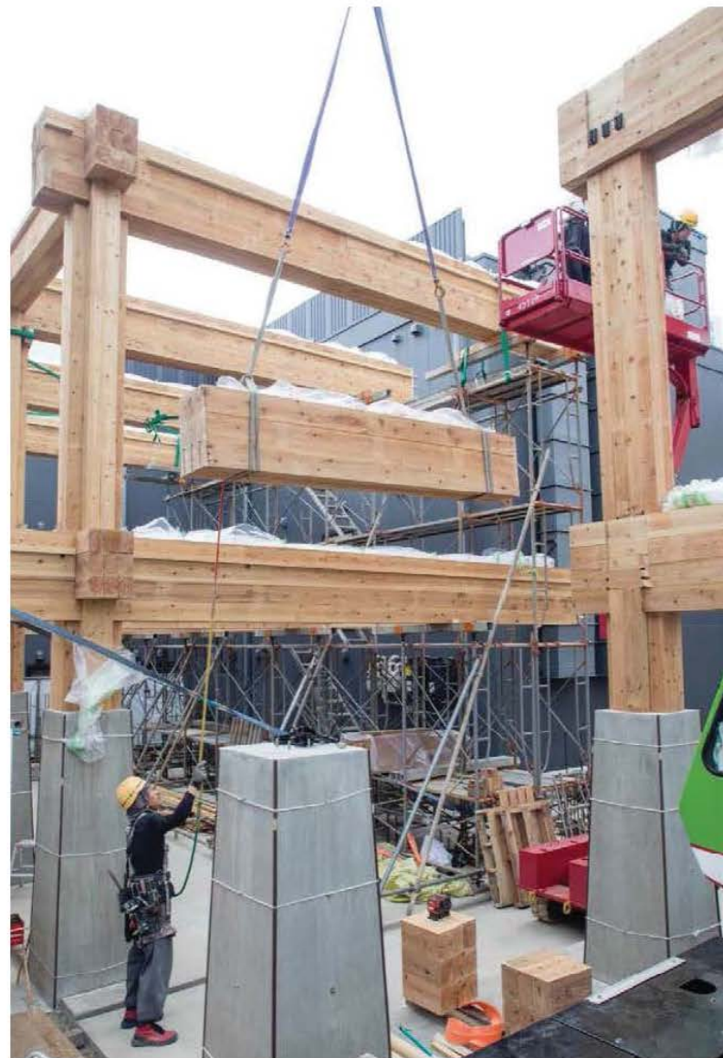
木構造の建方の様子。工場で束ね柱、重ね梁の製作を行い、現場で組み立てた。
