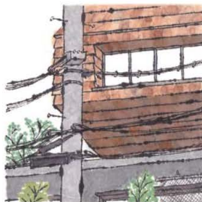
レッドシダの3階外壁
