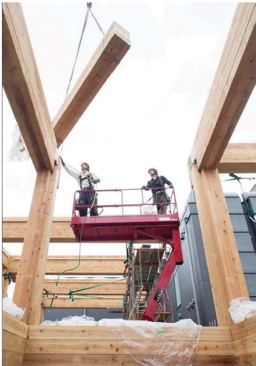
木構造の建方の様子。工場で束ね柱、重ね梁の製作を行い、現場で組み立てた。
