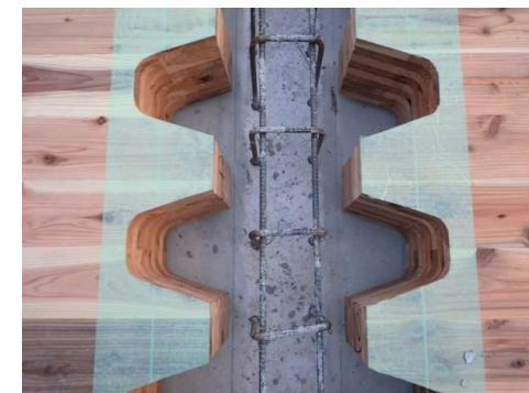
梁上部CLT屋根ブレース取合い
