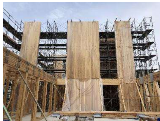
国内初のC L T張り合わせ3層通し壁柱
