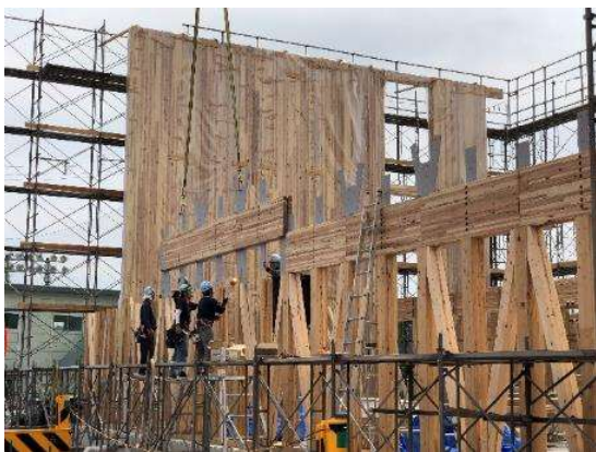
国内初のC L T張り合わせ3層通し壁柱
