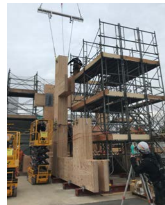
実大施工試験の様子
