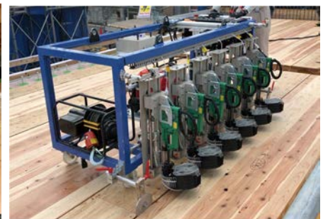
CLT 床版の連続ビス打ち機
