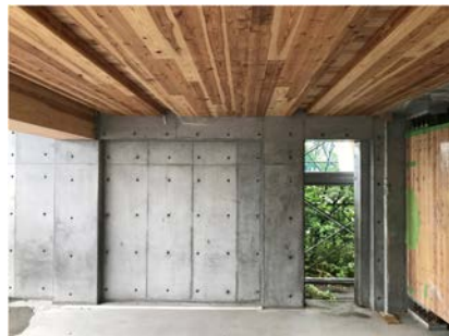
CLT を型枠兼仕上材として活用
