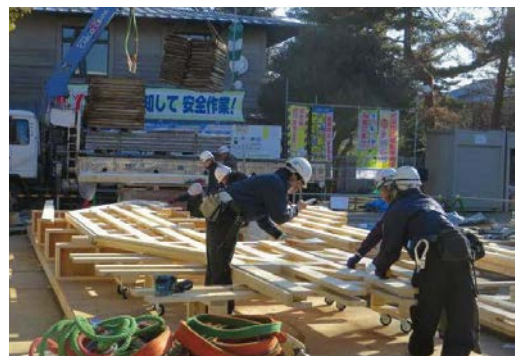
現場での地組み
