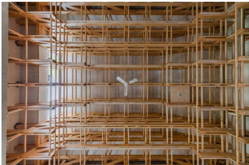
教室の架構の見上げ
