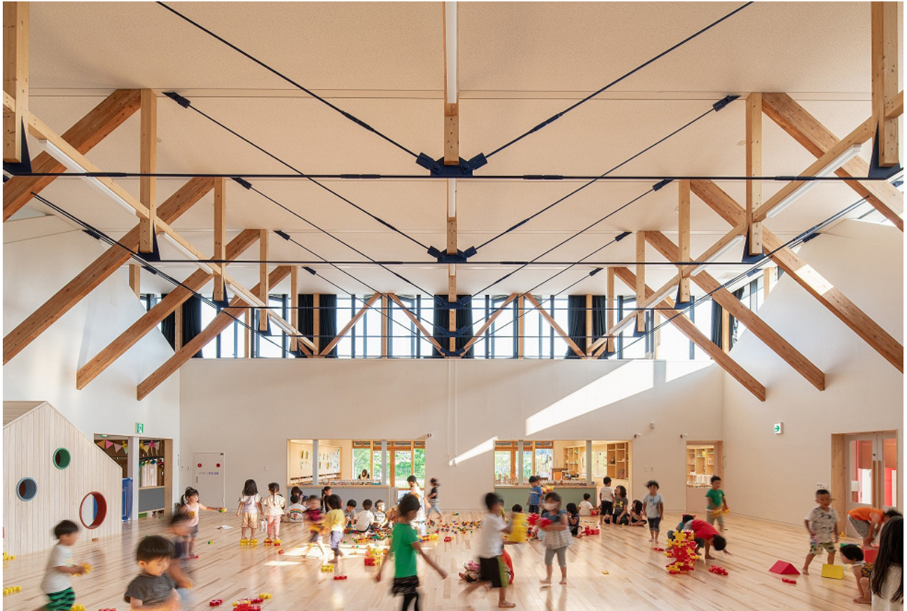
3ヒンジ方杖+張弦梁構造の遊戯室
