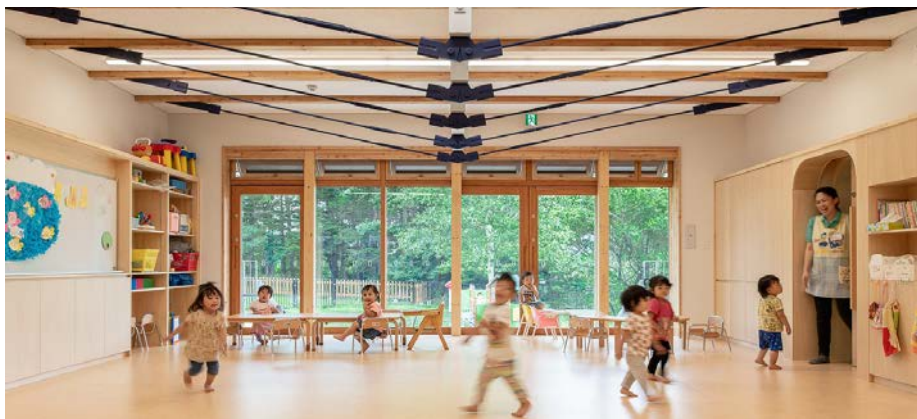
張弦梁架構の保育室
