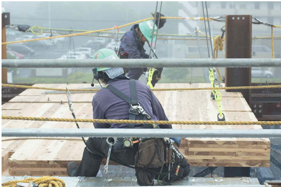
CLT 床版設置クレーン吊り込み工事
