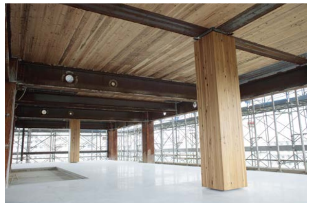
コンクリート施工完了
