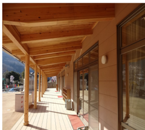
園庭に面したテラス
