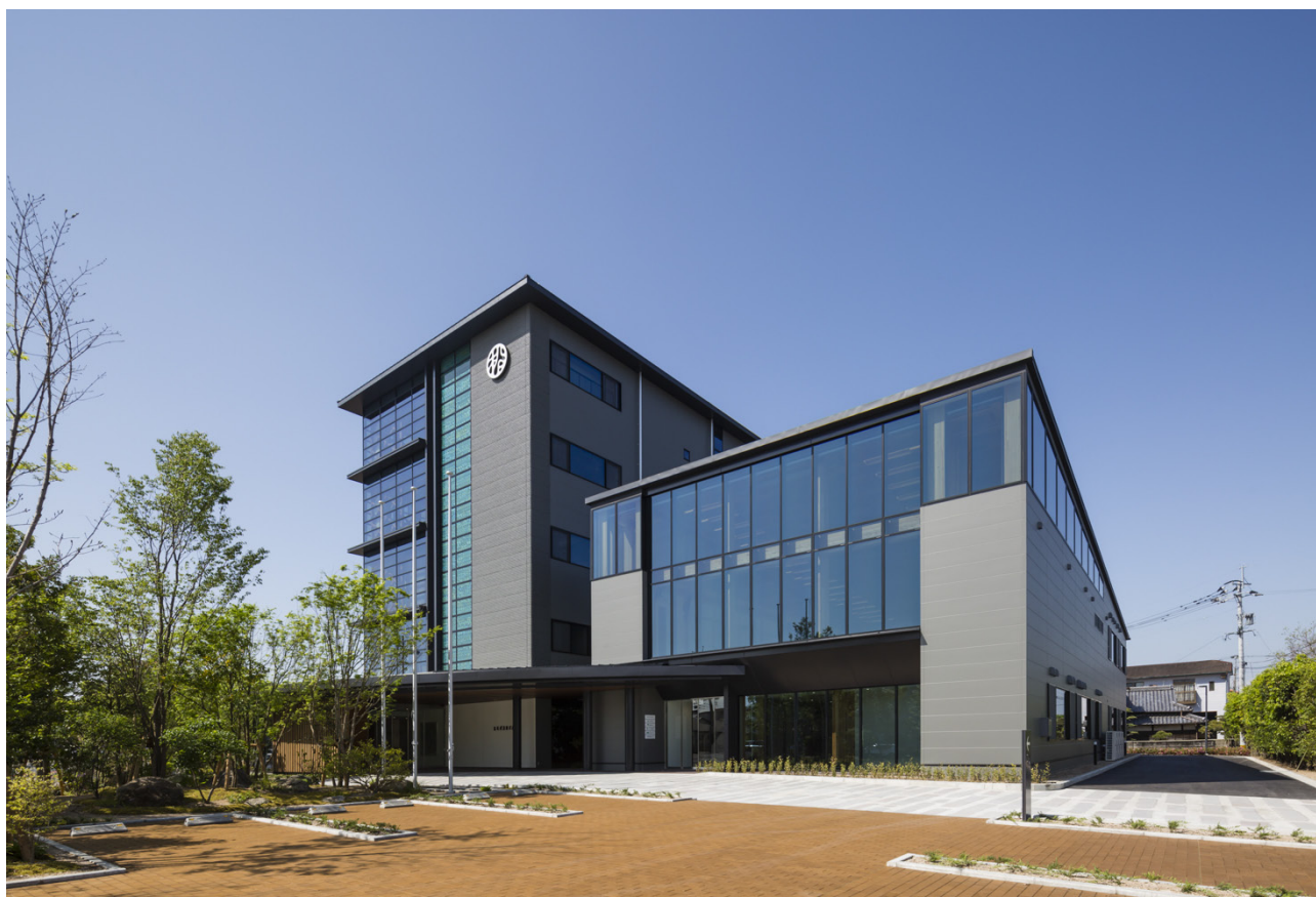
北東面外観 左：事務所棟、右：会議室棟
