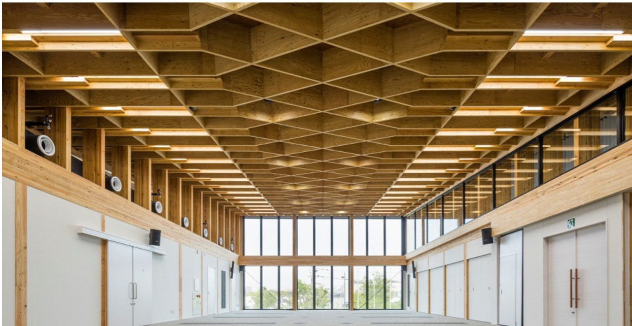
大会議室 ゲルバー桁橋の屋根架構
