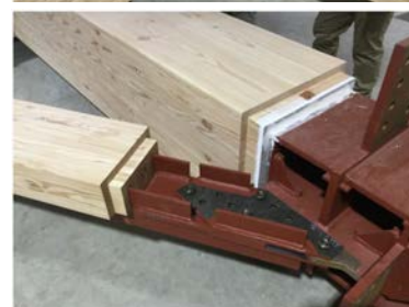
ハイブリッド集成材による柱・梁およびノンブラケット工法のジョイント部
