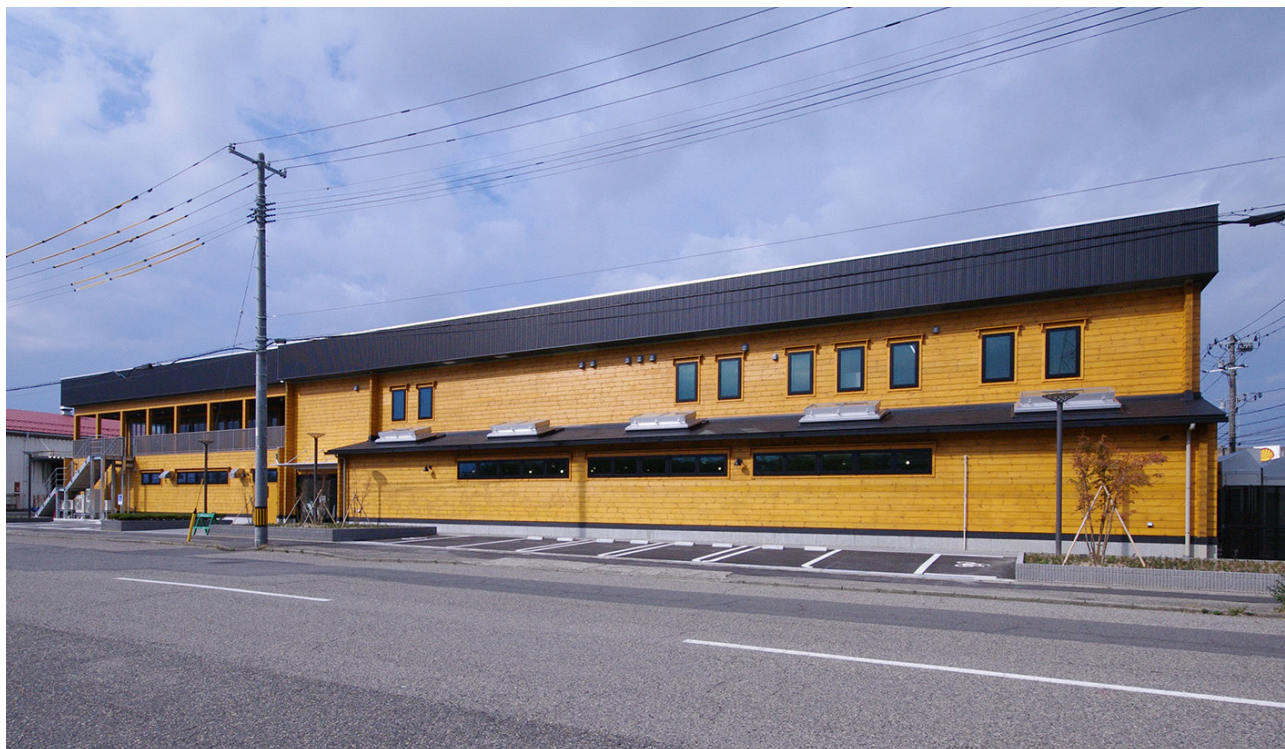
東側から見る外観
