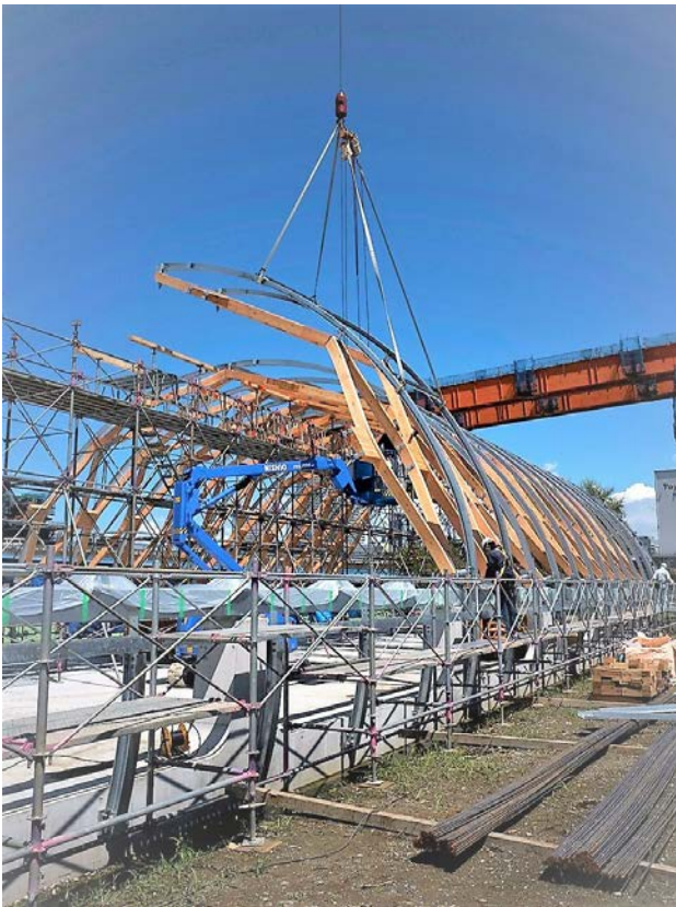
構造フレームの建て込み風景
