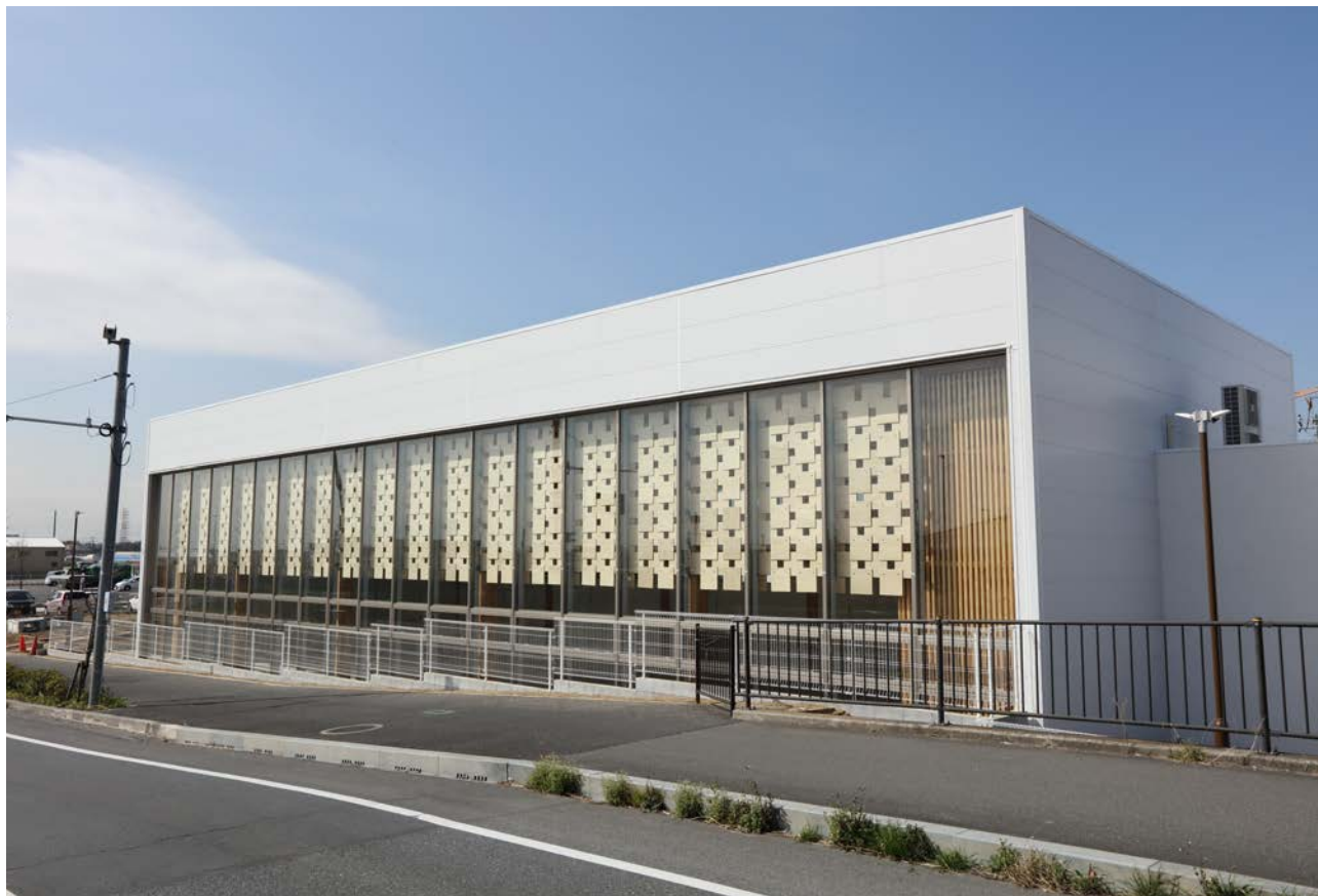
東側、実習棟の外観
