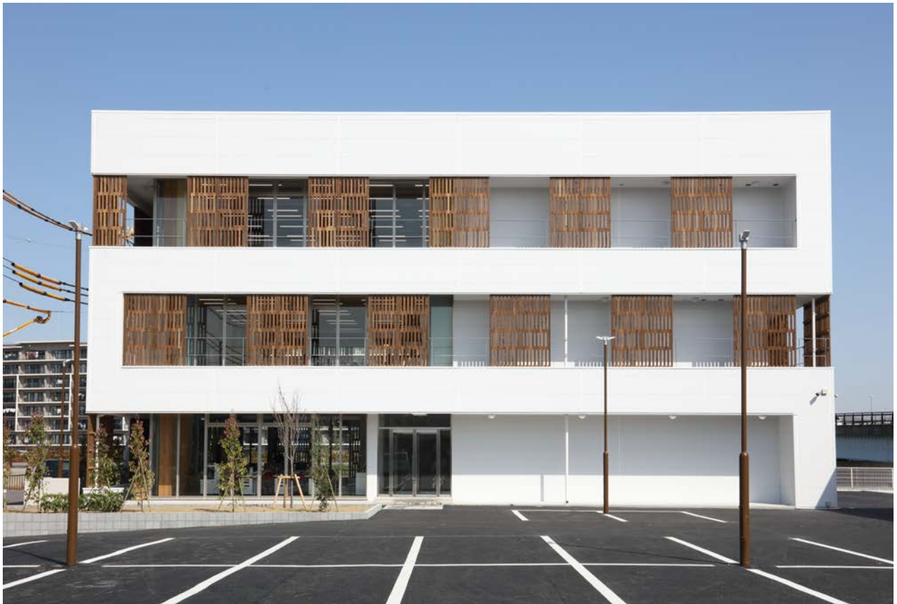
事務所棟の北側外観
